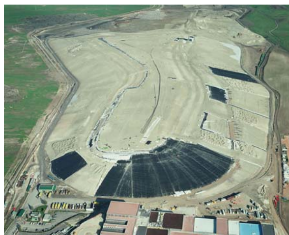
Foto 6. Sellado del Vertedero Sanitariamente Controlado de Pinto (Madrid).
