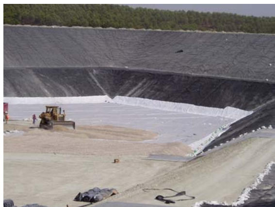
Foto 2. Extendido de gravas e instalación de la geomembrana y geotextil en el Vertedero de Pinto (Madrid)
