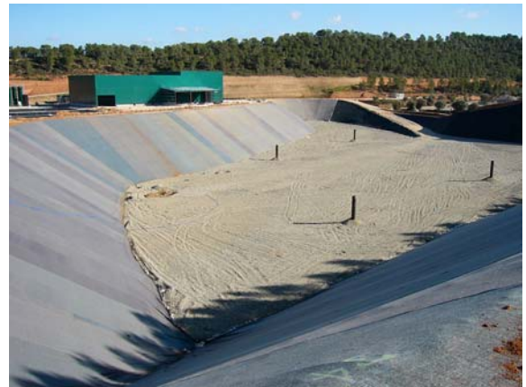
Foto 5. Vista del vaso del Vertedero de Mora la Nova (Tarragona)
