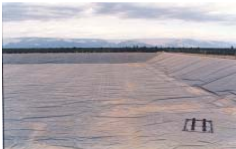
Fig. IV.2 Impermeabilización de balsa
