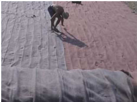
Fig. III 03. Subcapa de geocompuesto drenante y de protección, colector de drenaje
