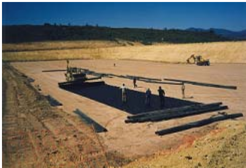
Fig. III.1 Corte de la geomembrana
