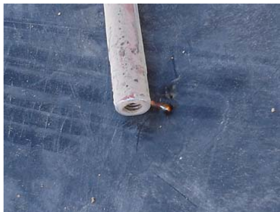
Fig. 17b El verificador detectando una perforación
