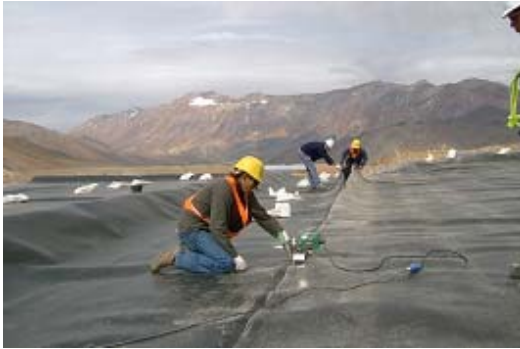
Fig. III 6 Soldadura mediante máquina con dispositivo de fusión mediante aire caliente
