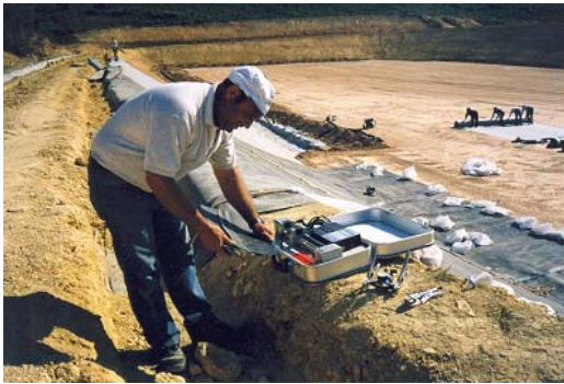
Fig. IV 10 Ensayo in situ de muestras de soldadura, soldadura.
