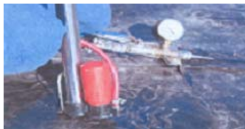
Fig. IV 12 Prueba de estanqueidad de una unión, con aire
