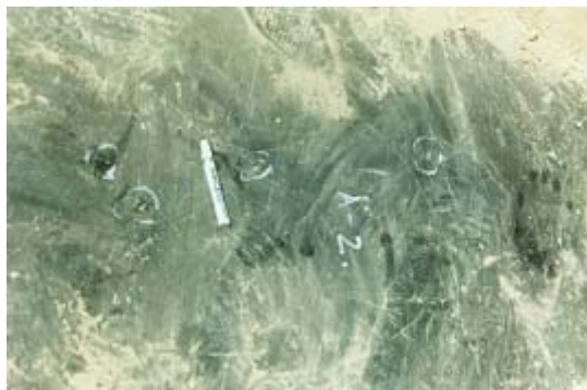
Fig. 15 Perforaciones causadas por cortes de piedras
