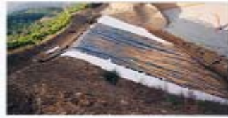
Fig. III 3b Talud con zanja de anclaje
