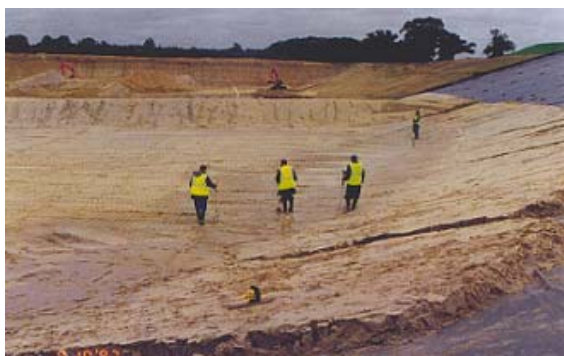
Fig. 21 Detectando fugas, con sensores móviles
