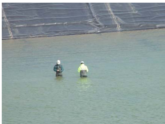
Fig. 21 Detectando fugas, con sensores móviles
