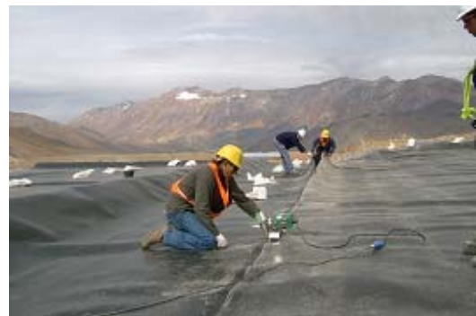
Fig. 6 Soldadura mediante máquina con boquilla de aire caliente
