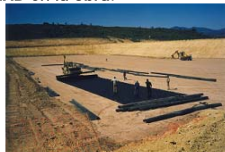
Fig. 2 Corte de la geomembrana
